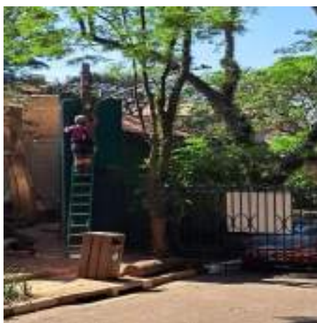
Figura 26 Manutenção/conserto dos fios de eletricidade pela Enel
